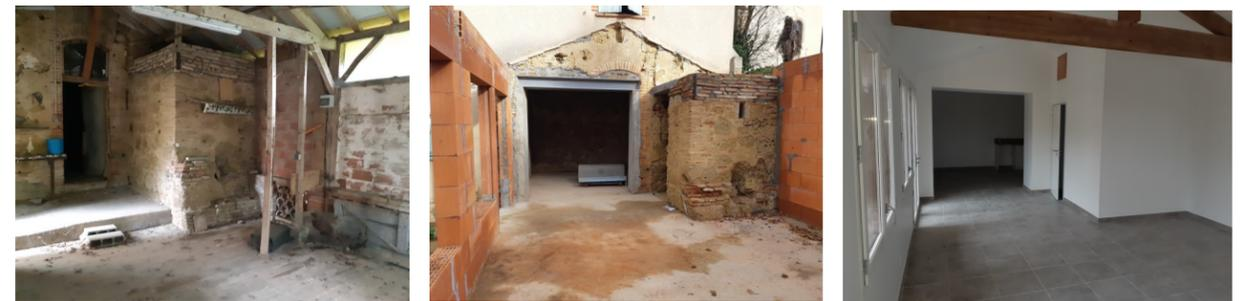
L'appentis de l'appartement du bas a été transformé en cuisine-salon : dépose de la charpente existante, création d'un hourdis béton (mise à niveau de l'ensemble), montage en parpaings des murs puis repose du toit avant l'aménagement intérieur.
